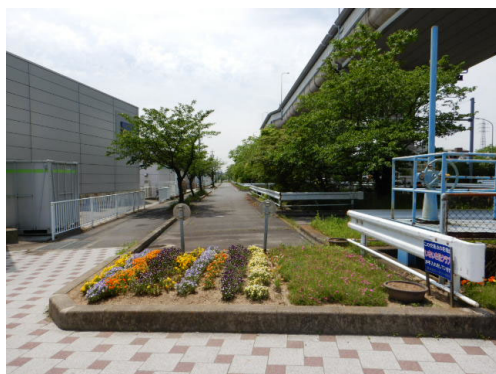
写真－環境施設帯 (国道 302 号)
