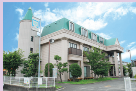
ハツ屋防災コミュニティセンター Yatsuya Disaster Prevention Community Center
