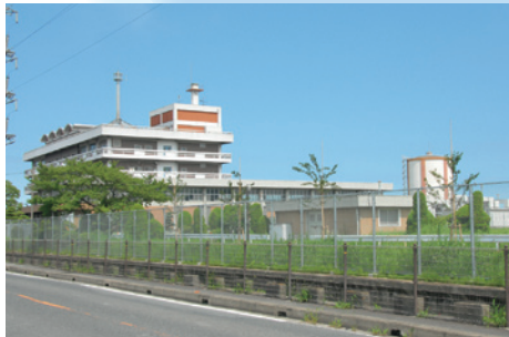
大治浄水場 Oharu Water Plant
